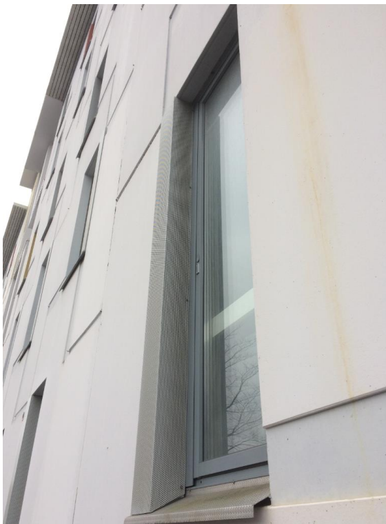
Kuva 6.2.3 Ääntä vaimentava kanavarakenne tuuletusikkunan edessä
